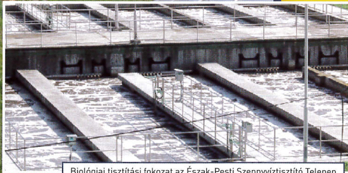
Biológiai tisztítási fokozat az Észak-Pesti Szennyvíztisztító Telepen
